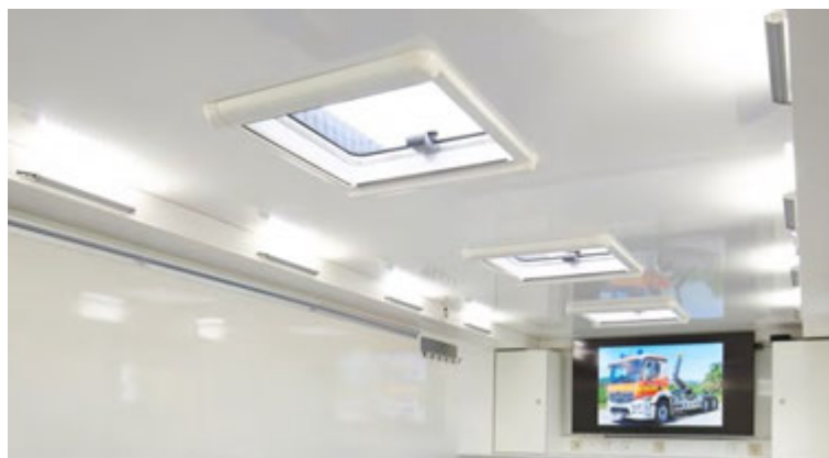
Abbildung 39: Blendfreie Beleuchtung durch indirektes Licht.
