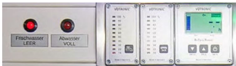
Abbildung 56: Überwachungspaneel der Hauswasseranlage und der Batterieanlage im AB.
