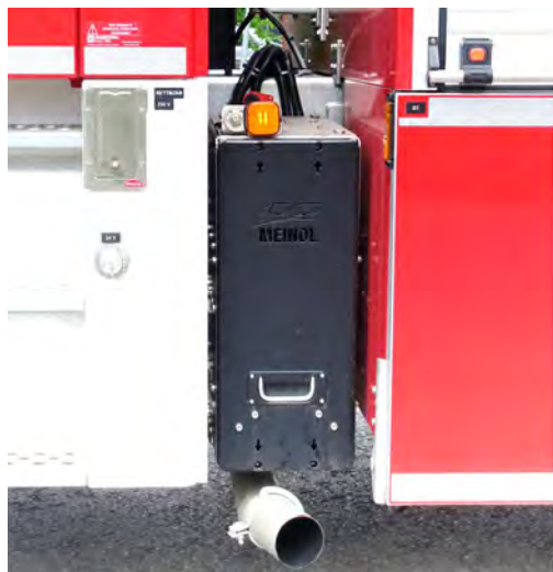
Abbildung 76: MEINDL-Batterieanlage mit Auszug.
