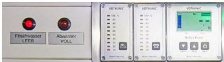
Abbildung 56: Überwachungspaneel der Hauswasseranlage und der Batterieanlage im AB.
