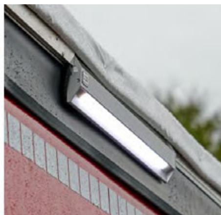
Abbildung 43: LED-Lichtstreifenelement Fabr. LDR, vorn und seitlich.
