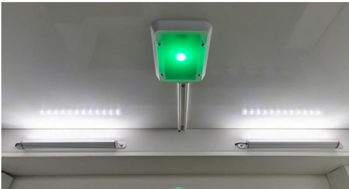
Abbildung 40: Lichtkörper der indirekten Beleuchtung und separate Nachtbeleuchtung (hier mit Grünlicht).
